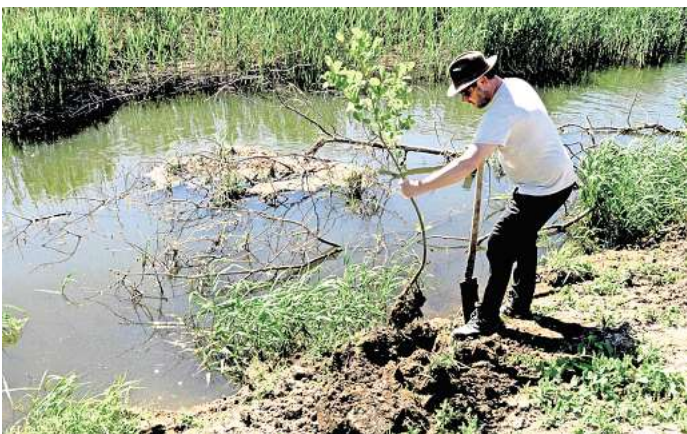
Einige Bäume konnte Sören Brose direkt an den Böschungsfuß setzen. Dort gelangen die Wurzeln auch im Sommer schnell ans Wasser und halten die Böschung fest.
