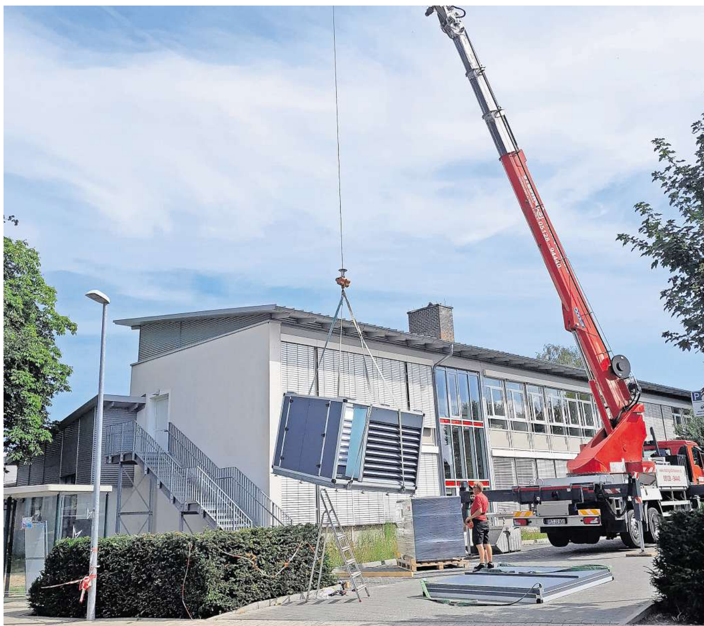
Zur energetischen Heizungsanierung erhält die Grundschule Lengede eine Wärmepumpe.
