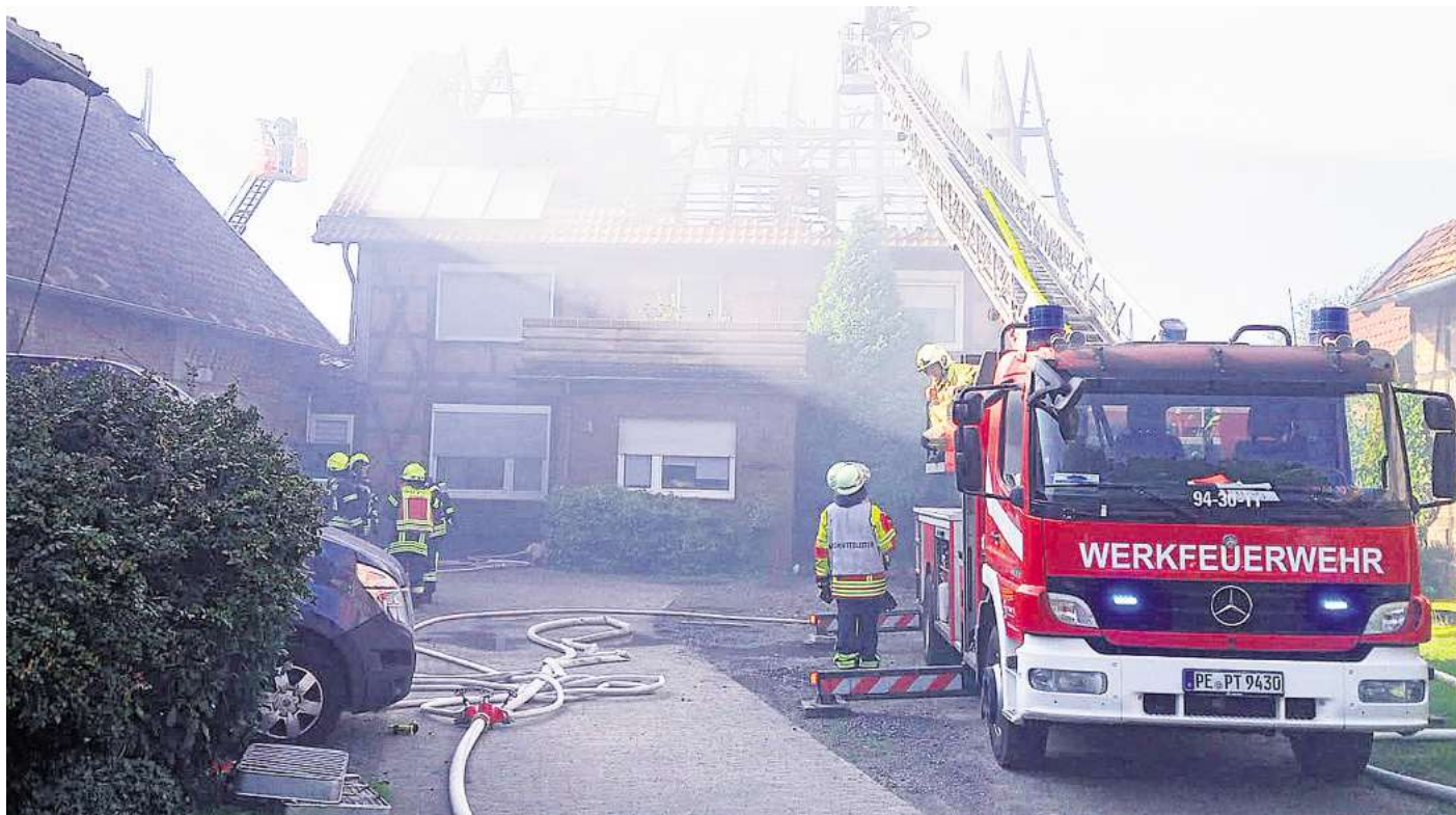
Nur noch ein paar Ziegel übrig: Der Dachstuhl des Hauses in Stederdorf ist komplett ausgebrannt.
