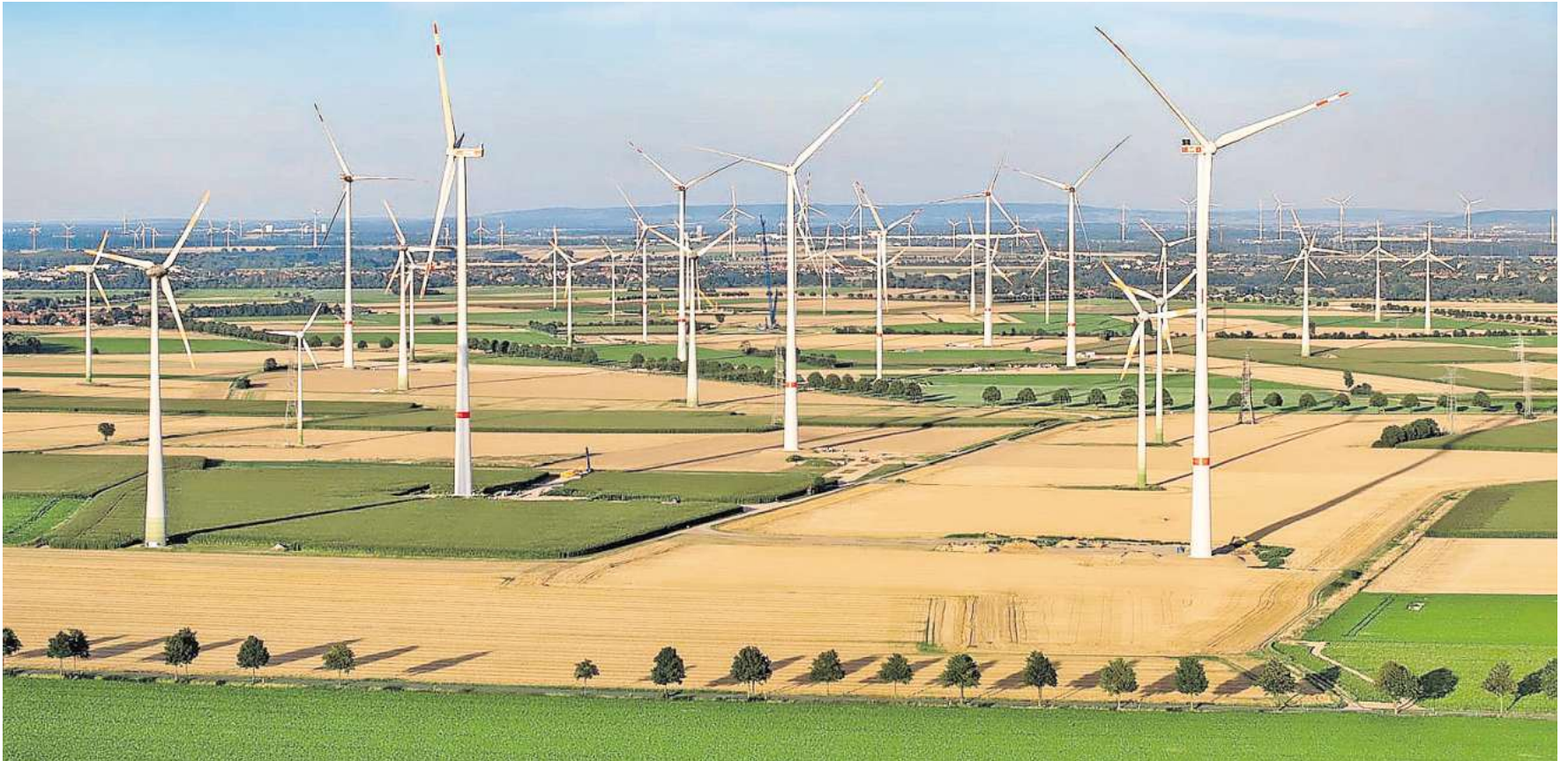
Klimafreundliche Energie: Einer der größten Windparks weit und breit ist nicht weit weg von Hohenhameln. Die Turbinen bei Lesse und Barbecke haben eine Gesamtleistung von 61,8 Megawatt.
