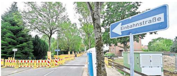
Hier dürfen Autos nur in eine Richtung fahren: Das Foto zeigt die Lindenbergstraße in Rosenthal. Wegen Bau-Arbeiten ist sie nur von Vöhrum oder der B65 aus in Richtung Ortsmitte befahrbar.
