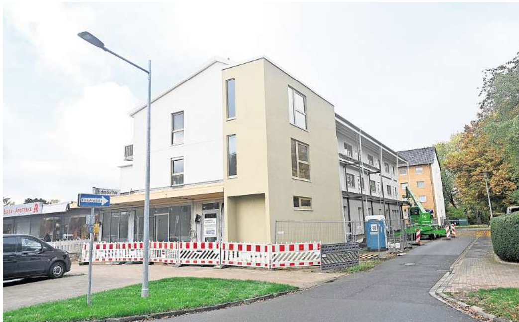
Auf der Zielgeraden ist das Bauprojekt an der Eichendorffstraße in Peine. Hier entstehen Wohnungen sowie das neue Hausarzt-Zentrum des Peiner Allgemeinmediziners Dr. Lars Peters. FOTO: RALF BÜCHLER
