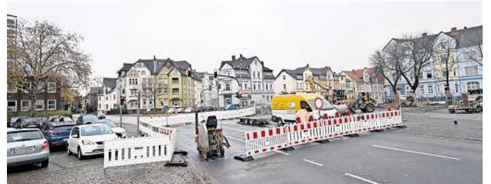
Gesperrt: Nichts geht mehr auf der Richard-Langeheine-Straße am Peiner Schützenplatz. FOTO: RALF BÜCHLER
