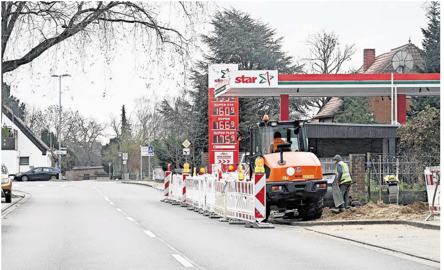
In Vöhrum verlegt derzeit die Telekom Glasfaser – hier an der Burgdorfer Straße.
