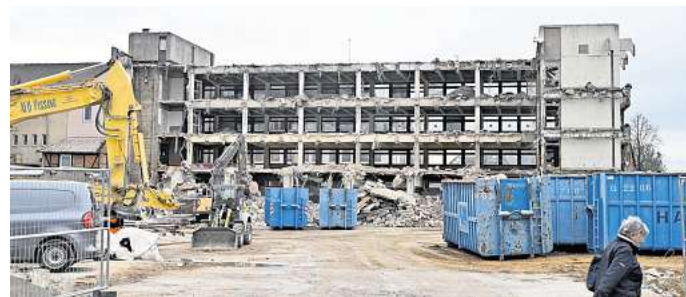
Abriss: Blick in das Innere des alten Postgebäudes an der Schützenstraße in Peine. FOTO: RALF BÜCHLER
