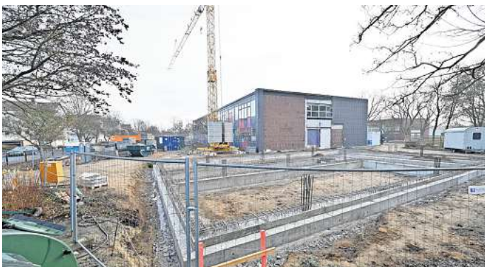
Die Peiner Grundschule in der Südstadt erhält einen Erweiterungsbau. FOTO: RALF BÜCHLER
