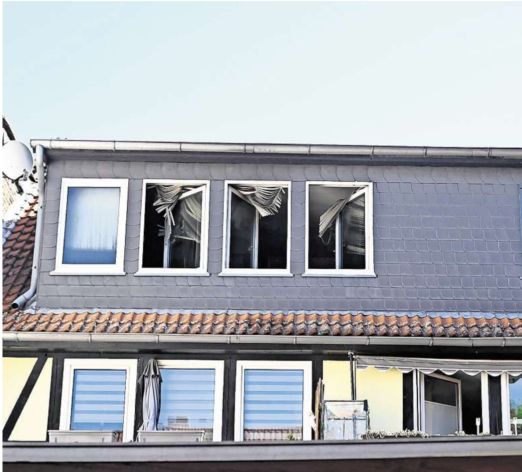
Bei dem Dachstuhlbrand wurde auch die Wohnung einer jungen Mitarbeiterin des Peiner Klinikums zerstört. Sie bittet um Spenden. FOTO: RALF BÜCHLER
