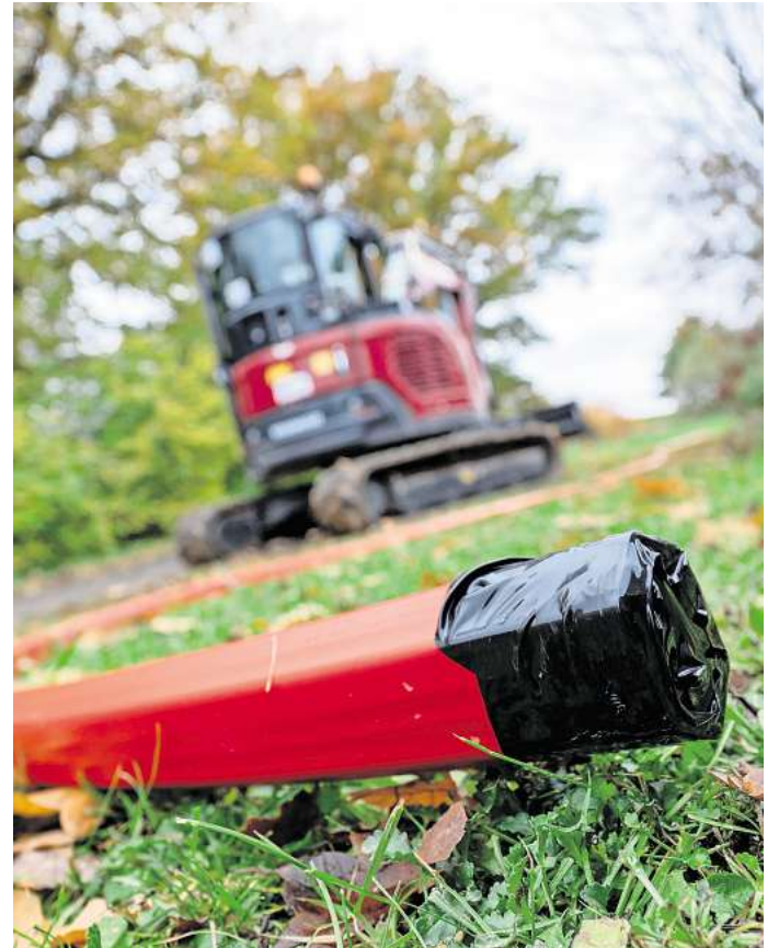
„Anschluss in Gefahr“ klingt dramatisch – Ruhe bewahren: Laut Verbraucherzentrale fällt ein bereits gebauter Hausanschluss nicht einfach weg, nur weil der Vertrag endet. FOTO: PIA BAYER
