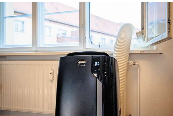
Achtung: Unterdruck! Der Abluftschlauch eines mobilen Klimageräts gehört durchs Fenster - am besten gut abgedichtet, etwa mit einer Acrylglasscheibe samt Loch für den Schlauch. Foto: Nico Tapia/dpa-mag
