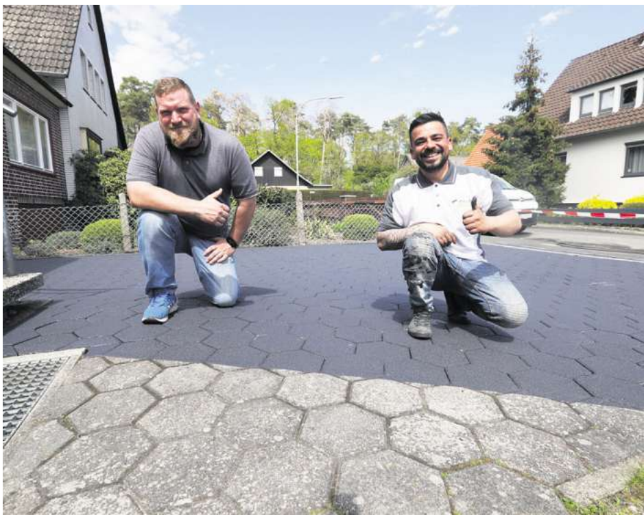
Eine mit dem ‚Steinfresh‘-Verfahren sanierte Pflasterung. Das geniale Pflegesystem verhindert Flechten und Schwarzalgen.
