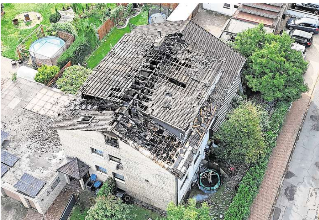
Der Tag nach dem Brand: Die Feuerwehr musste das Dach öffnen, um die Flammen bekämpfen zu können. Das Haus an der Straße „Am Tagebau“ in Ölsburg ist nach dem Feuer unbewohnbar. Foto: Ralf Büchler
