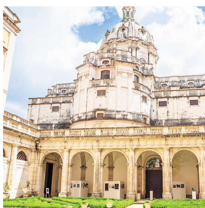
Der Nationalpalast in Mafra hat noch weit mehr zu bieten als die prachtvolle Bibliothek.
