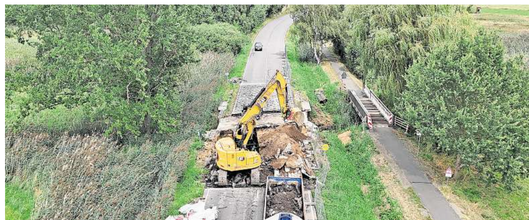
Dauerbaustelle zwischen Stederdorf und Edemissen: Die Schwarzwasser-Brücke wird erneuert.
