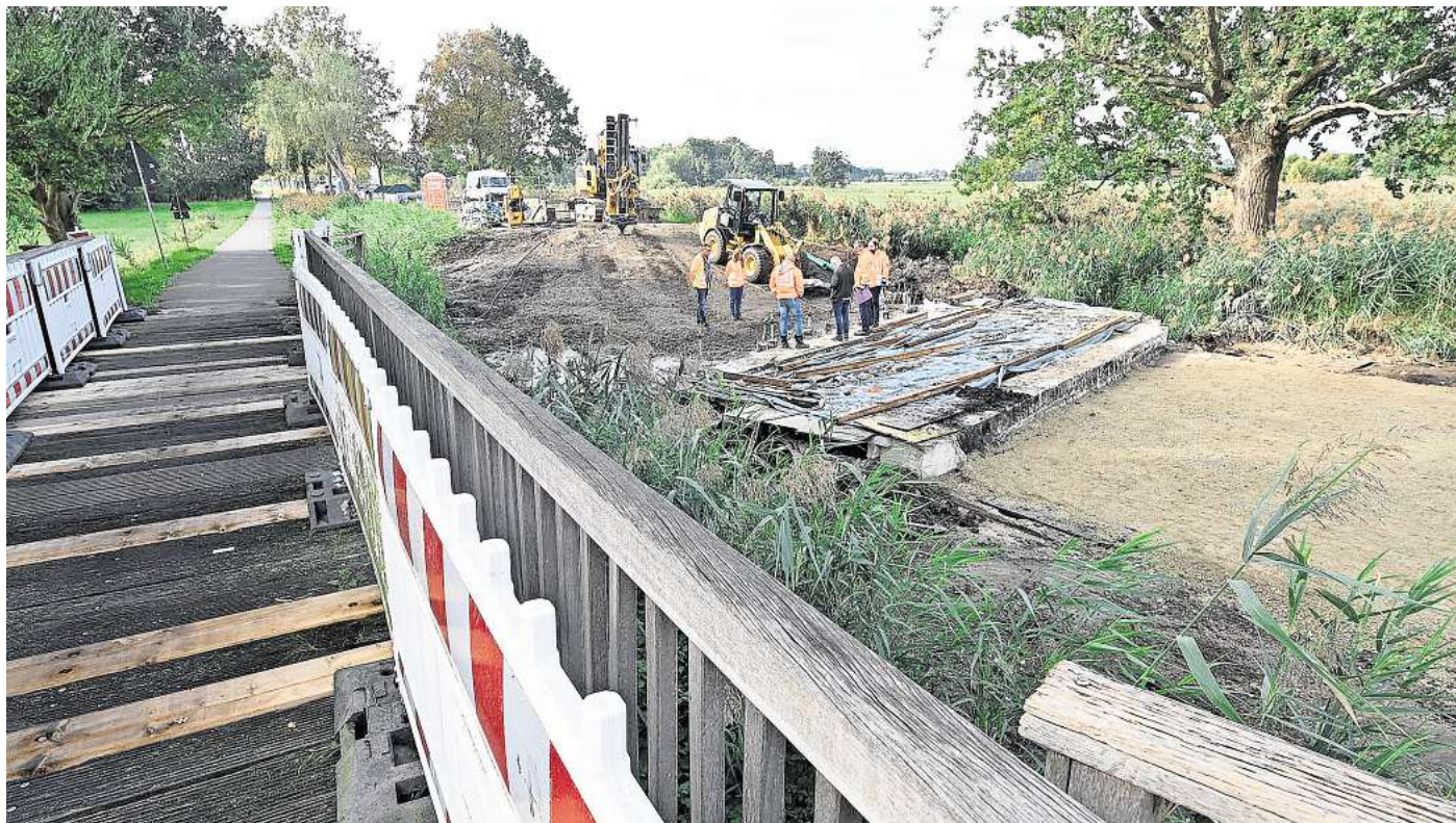
Erneuerung der Schwarzwasser-Brücke: Radfahrer und Fußgänger können die Holzbrücke noch nutzen.
