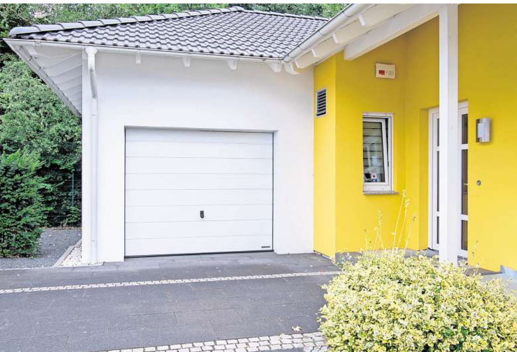
Nachbarn sollten mögliche Verstöße gegen genehmigte Bauvorhaben nicht über Jahrzehnte unbeachtet lassen.
