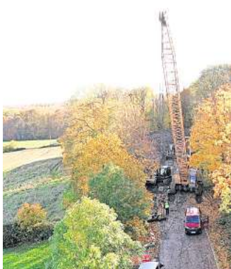
Drohnenflug über die Serpentine: Ein Seilbagger verdichtet den Erdboden unter der Burgbergstraße. FOTO: STADT SALZGITTER
