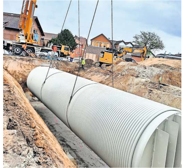
Mehr Wasser für den Ort: Die Feuerlöschzisterne wird in die vorbereitete Baugrube eingelassen. FOTO: GEMEINDE LENGEDE
