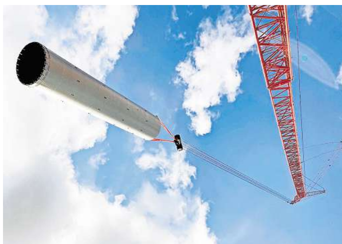
Aufbau eines Hybrid-Stahl-Turms: ENERCON setzt bei seinen Windrädern auf grünen Stahl, um die Umweltbilanz zu verbessern.
