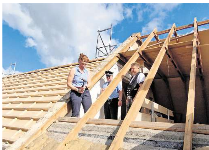
Richtfest bei der Feuerwehr: Bürgermeisterin Maren Wegener schlägt einen Nagel in den Sparren des Gerätehauses in Barbecke.
