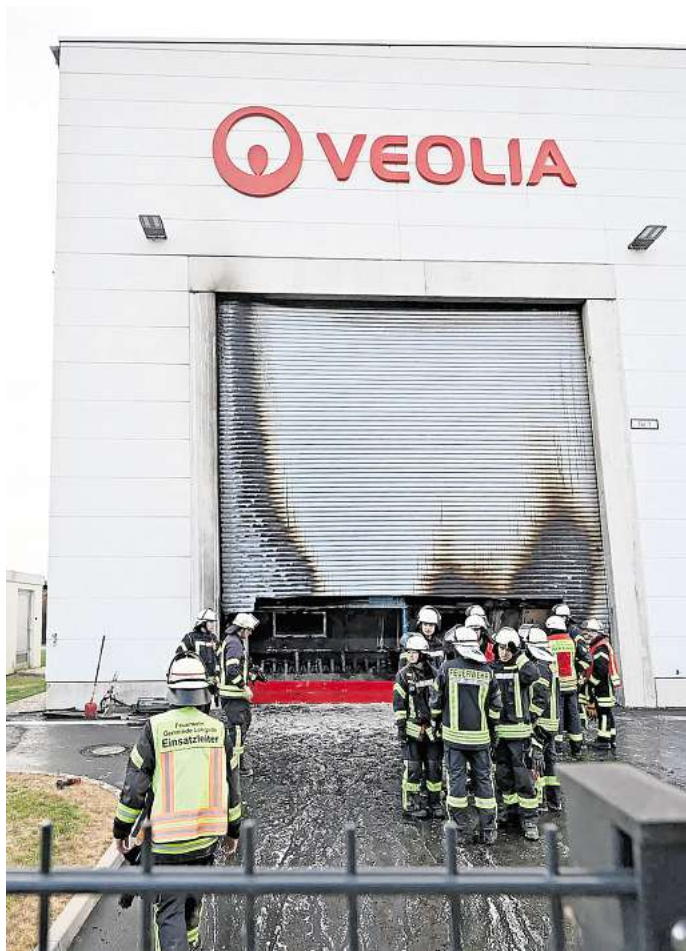
Großeinsatz in Broistedt: In der Holzaufbereitungsanlage von der Firma Veolia hat es gebrannt, die Folgen blieben aber überschaubar.
