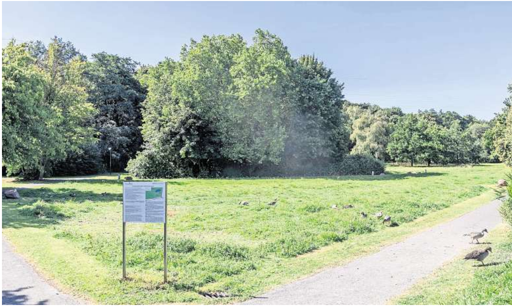
Die Bauarbeiten beginnen: In der Grünanlage Spackenkamp in Gebhardshagen wird eine Pumptrackanlage errichtet.
