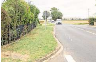
Baustart noch unklar: Der neue Radweg führt von Salder zur Nord-Süd-Straße. FOTO: SZ-PA/RK
