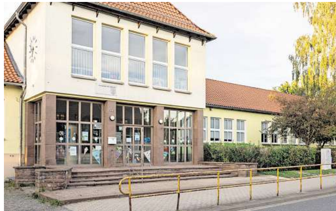
Teilweise gesperrt: In der Grundschule Hallendorf wurde im Ostflügel eine zu hohe PCB-Belastung gemessen. FOTO: SZ-PA/WRK
