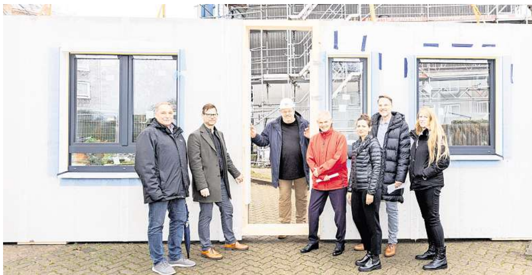
Beobachteten den Einbau der Fassadenteile: Matthias Giffhorn (WEVG), TAG-Baumanager Dirk Förster-Wehle, Alexander Fuchs (Firma B&O), OB Frank Klingebiel, TAG-Chefin Daniela Stark, Baudezernent Michael Tacke und TAG Immobilienmanagerin Debora Aselmeyer trafen sich zur Baustellenparty an der Suthwiesenstraße.
