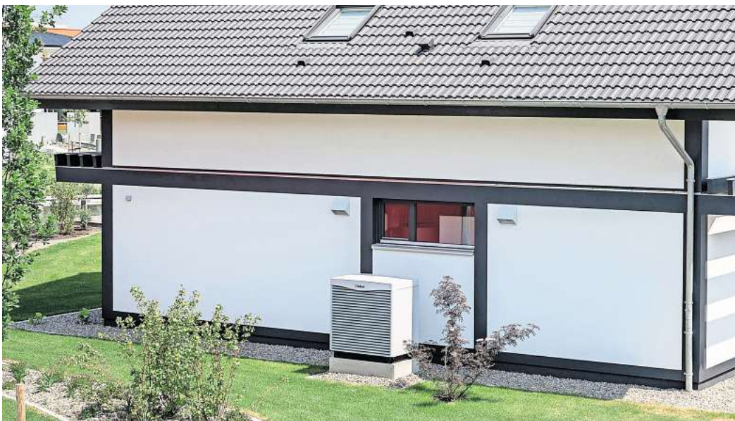
Die Luft-Luft-Wärmepumpe entzieht der Außenluft Wärme, um damit die Raumluft zu erwärmen. Sie kann aber auch Räume kühlen. Foto: Daniel Maurer/dpa-mag
