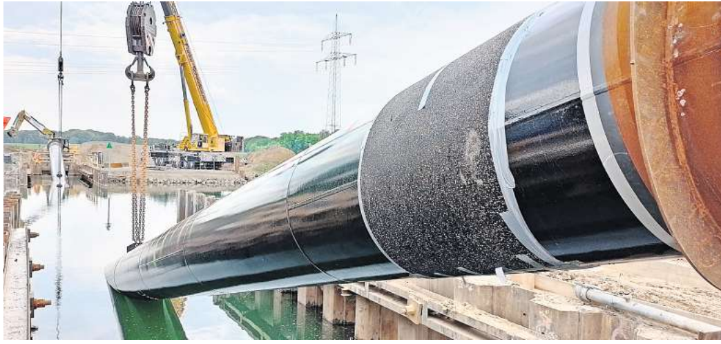
Der Düker 482 ist im Wasser: Durch das große Stahlrohr fließt später der Dentorfer Bach unter dem Stichkanal durch. FOTO: WASSERSTRASSEN-NEUBAUAMT HELMSTEDT
