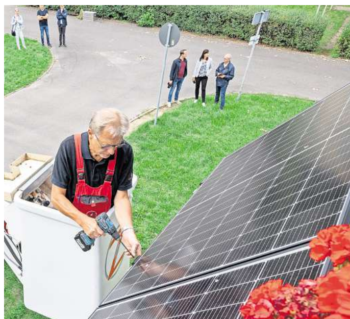
Montage-Arbeiten an einem Balkonkraftwerk. FOTO: HENDRIK SCHMIDT
