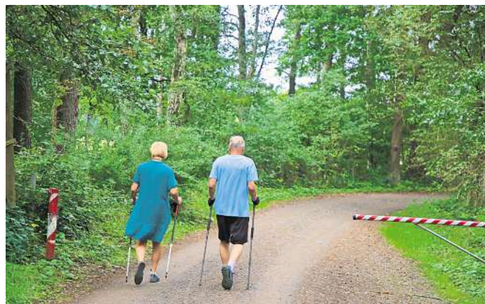
Da passen nicht nur Nordic-Walker durch: Die Schranke an der Verlängerung des Wittkopsweges nahe der Schicke-Brücke ist beschädigt. Auf der anderen Seite ist das Schloss einer Schranke beschädigt, so dass sich problemlos durchfahren lässt. FOTO: GERO GEREWITZ
