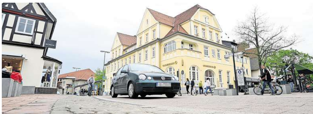
Hindenburgstraße: Der Umbau der Rendezvous-Haltestelle beginnt am Montag, 13. April. Damit kommen auf den motorisierten Individualverkehr dauerhaft erhebliche Veränderungen zu.
