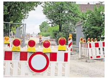
Vor allem im nördlichen Abschnitt gibt es bis Juni noch einiges zu tun. FOTO: GERO GEREWITZ
