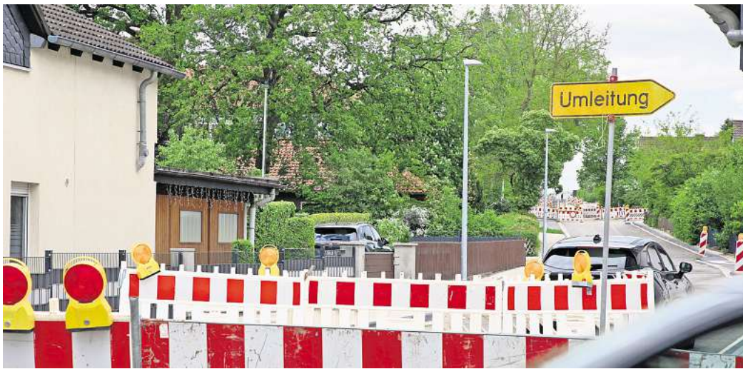
Dauerbaustelle in Gifhorn: Seit August 2024 laufen die Arbeiten auf der etwa 300 Meter langen Fritz-Reuter-Straße. FOTO: GERO GEREWITZ
