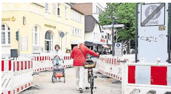
Durch diese hohle Gasse werden sie nicht kommen: Die Umzüge zum Gifhorer Schützenfest werden die Baustelle Hindenburgstraße umgehen. FOTO: SEBASTIAN PREUB
