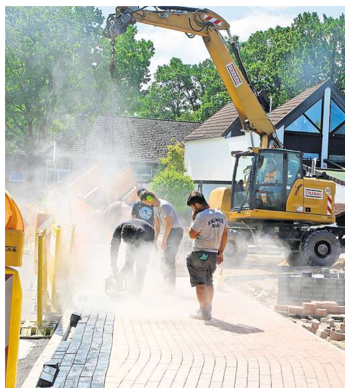
Der Staub kündigt von fleißigen Bauarbeitern: Hier entsteht die neue Gehweg-Querung des Sonnenwegs an der Einmündung Calberlaher Damm.
