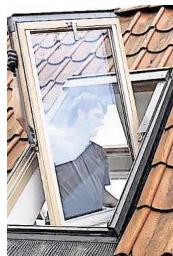
Der Einbau neuer Fenster hilft dabei, Wärmebrücken zu vermeiden. FOTO: VELUX
