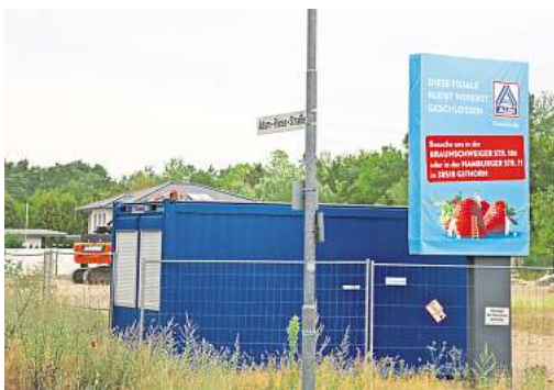
Vor rund zwei Jahren legte ein Großbrand den Aldi-Markt an der Adam-Riese-Straße in Schutt und Asche.
