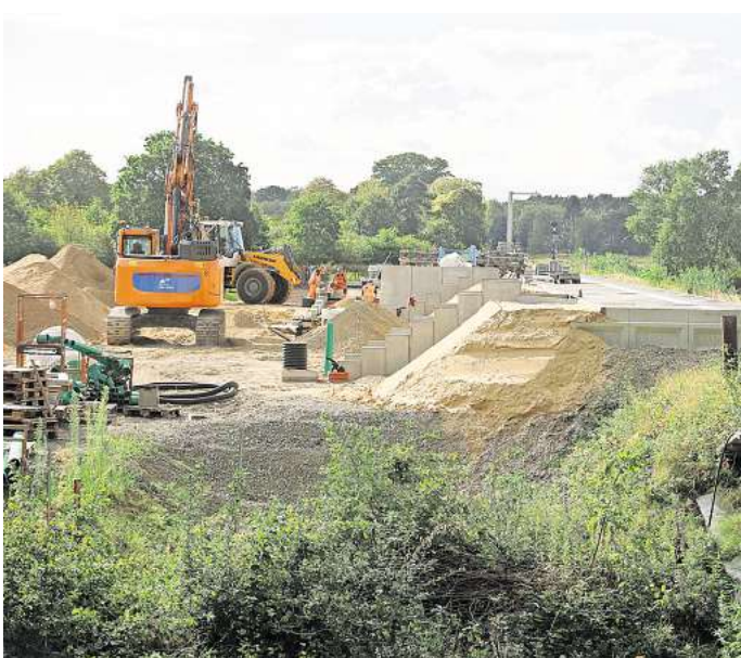
Baufortschritt am Bahnhof Isenbüttel: Der Bahnsteig sieht schon nach Bahnsteig aus. Foto: Gero Gerewitz
