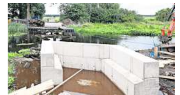
Neue Brücke: Die Widerlager stehen schon.
