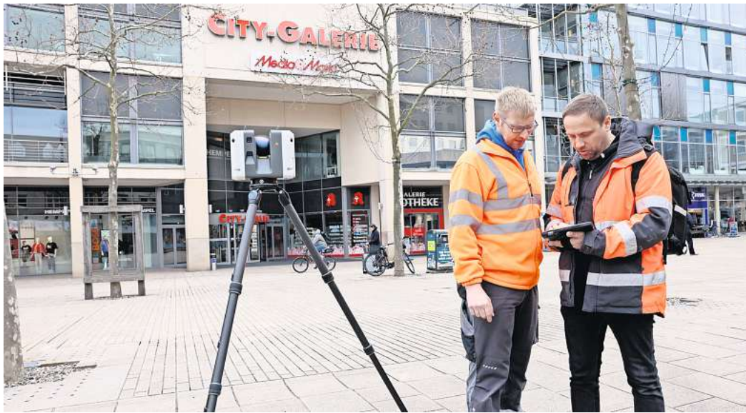
Die Mitarbeiter der Entricon stehen mit dem Laserscanner in der Wolfsburger Innenstadt: Mit den Daten wird der digitale Zwilling erstellt.
