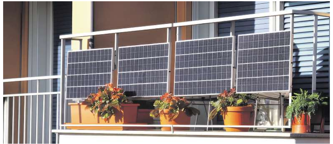
Solarmodule für ein sogenanntes Balkonkraftwerk hängen an einem Balkon.
