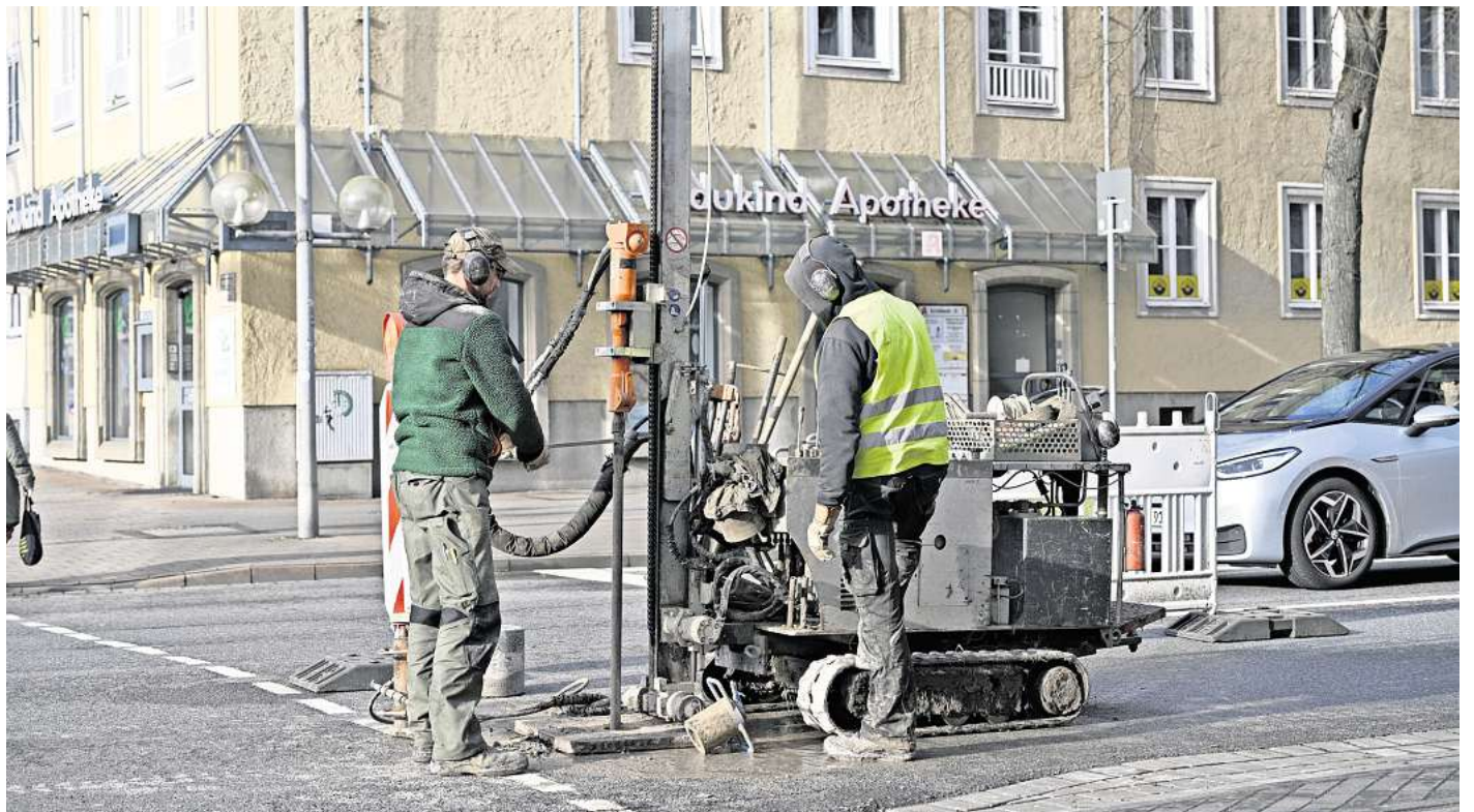
Blick in die Unterwelt: Experten führten am Samstag Probebohrungen in der Schillerstraße durch. Sie untersuchen den Boden im Vorfeld von Leitungsarbeiten.
