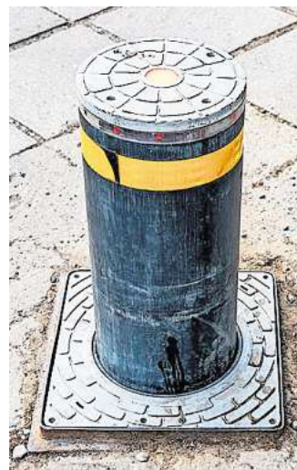
In der Wolfsburger Innenstadt sollen auch versenkbare Poller installiert werden. TIMLTV/123RF
