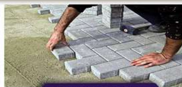
Pflasterverlegung
