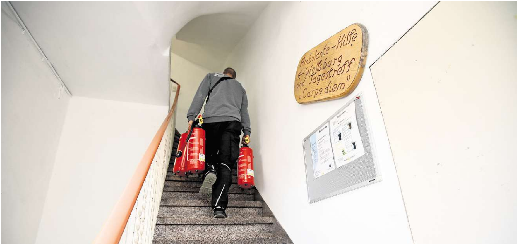
Schwieriger Zugang: Über diese Treppe gelangt man zum Tagestreff.
