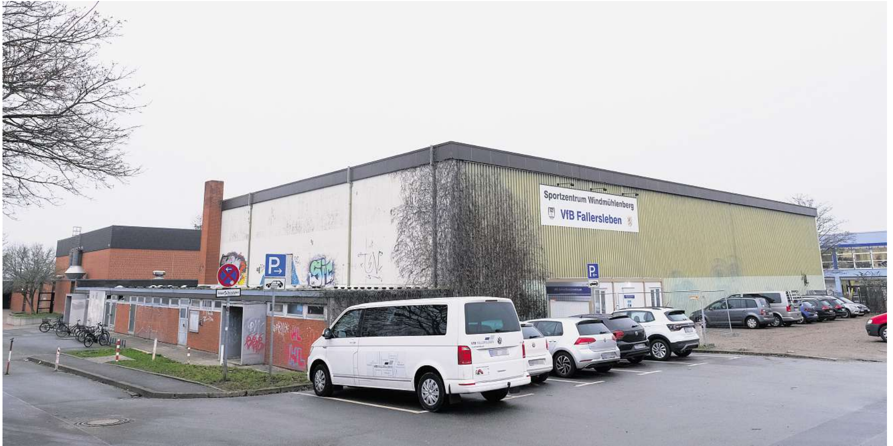
Die Sporthallen in Fallerleben sind marode: Die Stadt will sie mit finanzieller Hilfe des Bundes abreißen und neu bauen.
