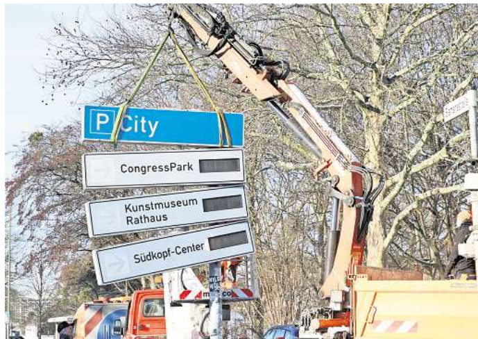
Das alte Parkleitsystem, wie hier in der Siemensstraße, wird abgebaut.
