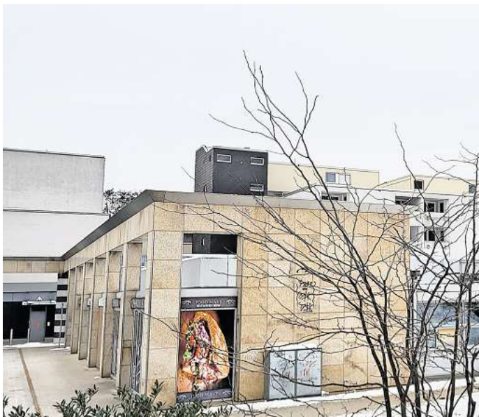
Das EKZ Westhagen, voraussichtlich im Sommer soll mit dem Abriss begonnen werden. FOTO: OLIVER FRICKE
