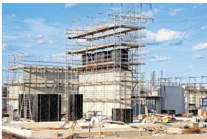
Der Timberjacks-Rohbau in Fallersleben nimmt immer mehr Gestalt an.
