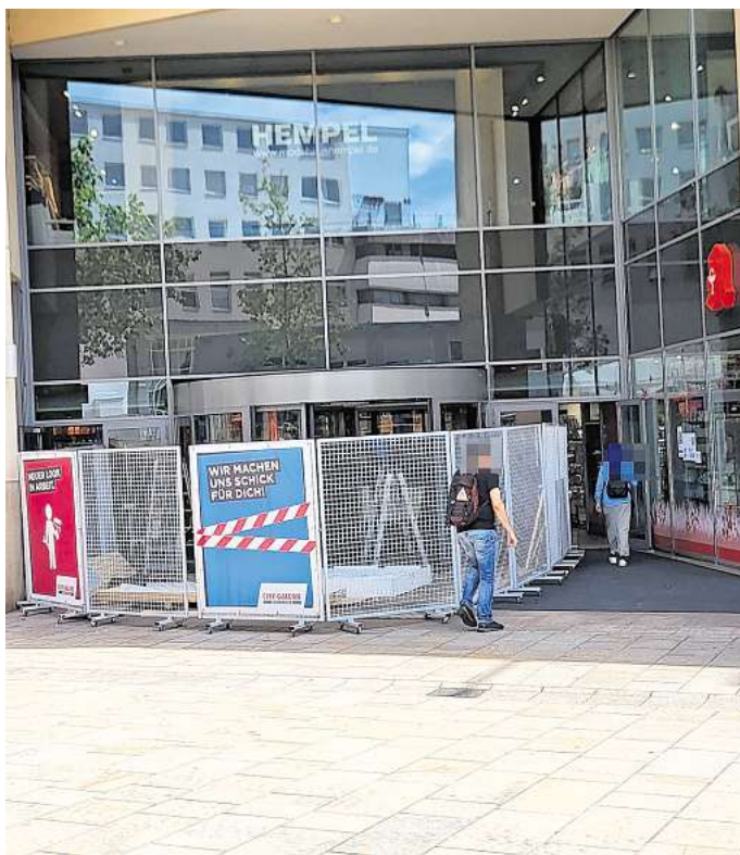
In der City Galerie laufen zur Zeit Bauarbeiten im südlichen Eingangsbereich. Die Drehtrommeltüren werden an beiden Eingängen ausgetauscht.
