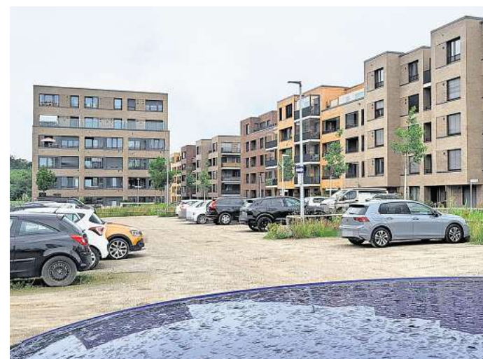
Der Parkplatz am Arnikaweg in den Steimker Gärten bietet 70 Stellplätze und bleibt vorerst bestehen.
