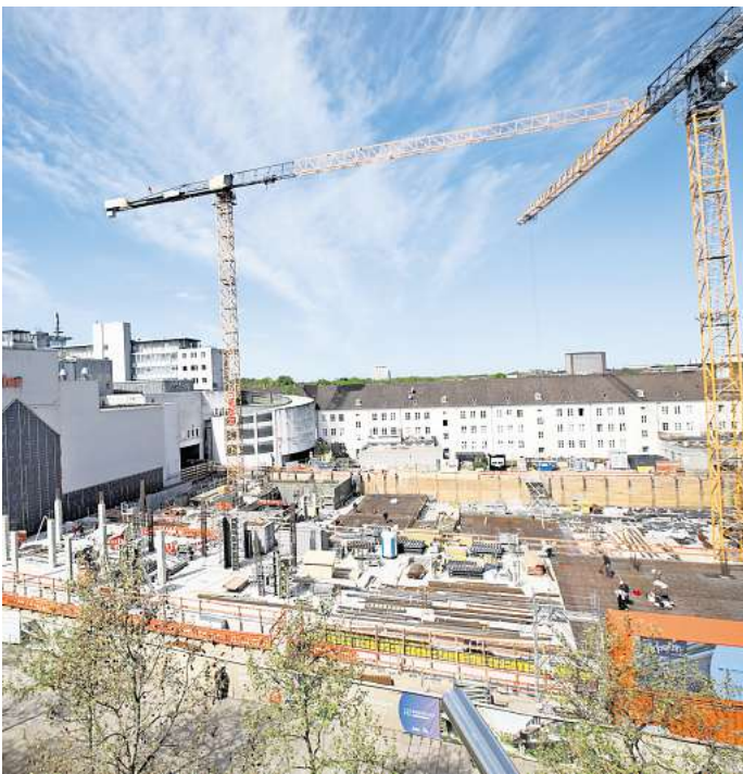
Blick auf die Baustelle der Brawo Arkaden in der Porschestraße. Foto: Britta Schulze
