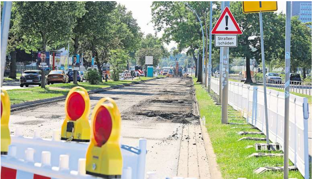
Voraussichtlich bis zum Ende der Sommerferien sollen die Bauarbeiten auf der Heinrich-Nordhoff-Straße andauern. Foto: Gero Gerewitz
