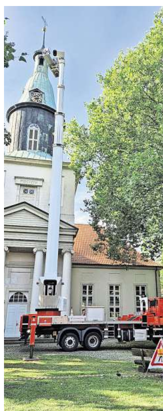
Der Hubsteiger im Einsatz.
